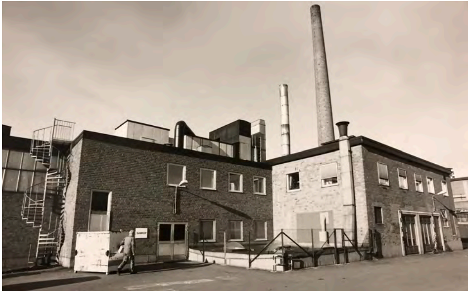
Panncentralen intill tidigare personalutrymme i två våningar med tvättrum och omklädningsrum. Foto: Gaston Salas 1992, Nacka lokalhistoriska arkiv.
