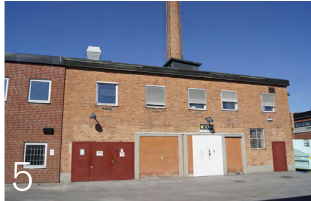
Panncentralen med karaktärsskapande skorsten. Flertalet dörrar har ersatt fönster. I söder ansluter en senare tillkommen volym.
