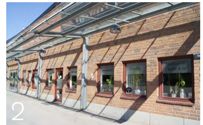
Skärmtak i glas löper längs södra och norra fasad som stöds av stålpelare.
