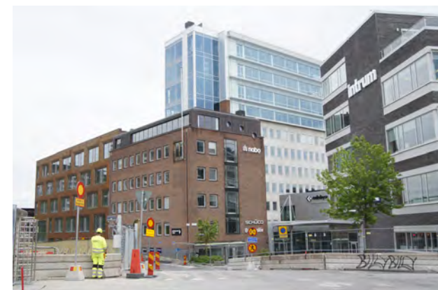
Bilden visar Atlas Copcos tidigare huvudkontor, tillbyggnader och senare tillkomna volymer som skapar en stadsmässig miljö.
