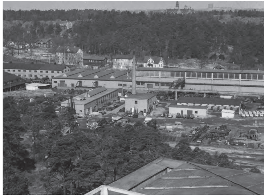
Vy från tak på Atlasberget. På bilden syns industri området innan Sirocco byggdes. Panncentralen finns redan och ger en idé om hur den såg ut innan den byggdes samman med verkstaden. På gaveln anas ett spröjsat fönster. Bild: Stockholms länsmuseum.
