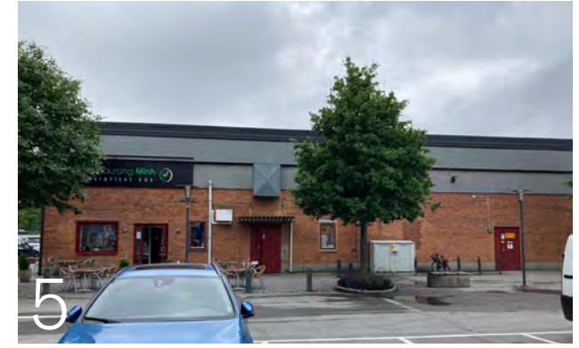
5 Östra fasaden med assymetrisk placering av fönster.
