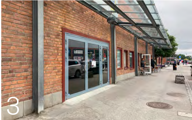
3 Södra fasaden med flertalet dörrar och variation av fönster.
