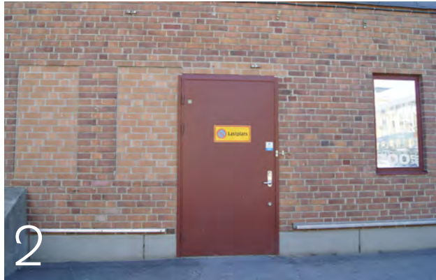
Flera igensatta fönster är synliga i fasaden.
