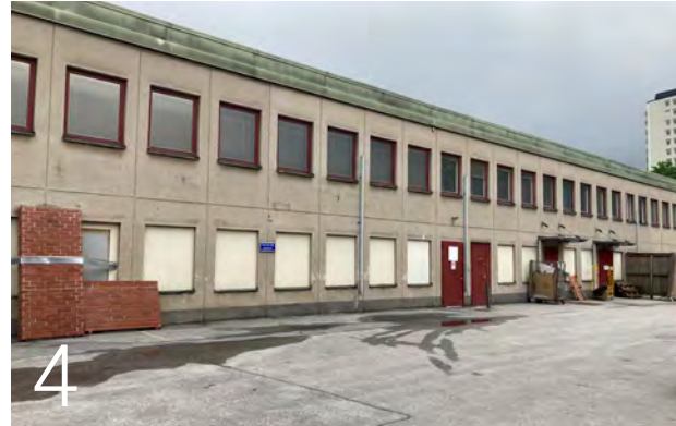
4 Rytmsikt placerade fönster på västra fasaden.
