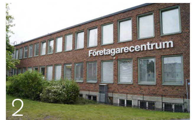
Bilden visar källarvåningens fönster på den västra fasaden.
