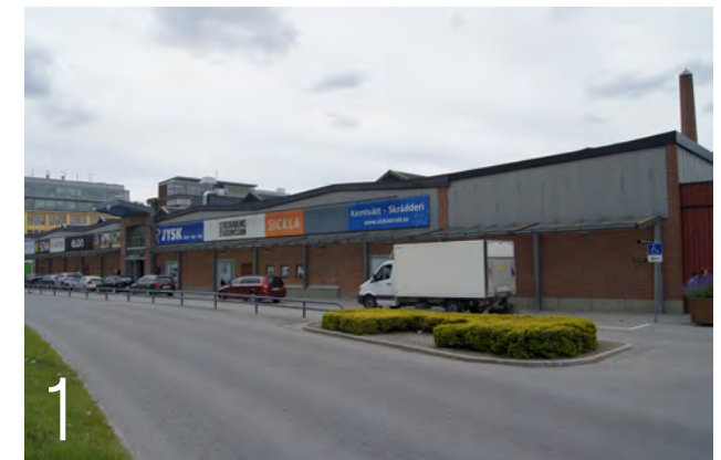
Södra fasaden möter bilväg och parkering. Igensatta fönsterband och ett fåtal fönster upptagna i fasaden.
