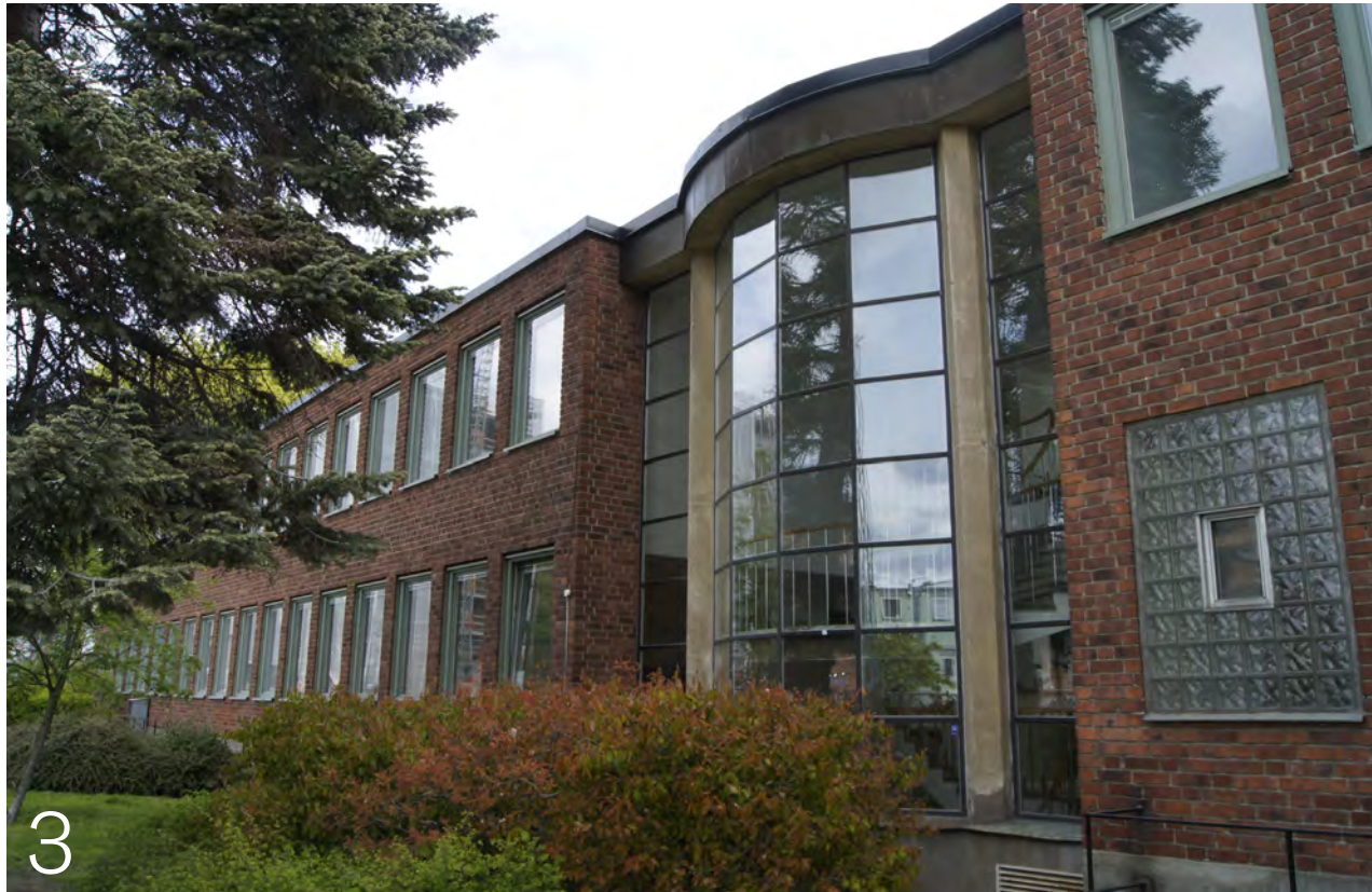
Det glasade partiet på västra sidan är formad som ett absidliknande burspråk vars runda form bryts av vertikala pelare. Taket följer den runda formen. Till höger syns ett fönster i galsbetong. Byggnaden ligger i anslutning till en mindre park.
