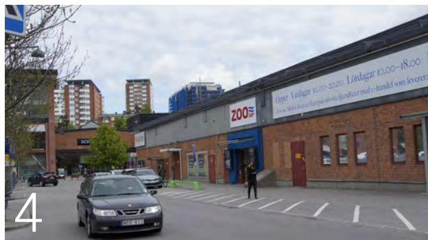
Avlånga fönster placerade i grupper. Flertalet dörrar har tagits upp i fasaden. I fonden syns Alphyddans bebyggelse vars tegelfasader ansluter till det gamla industriområdet.
