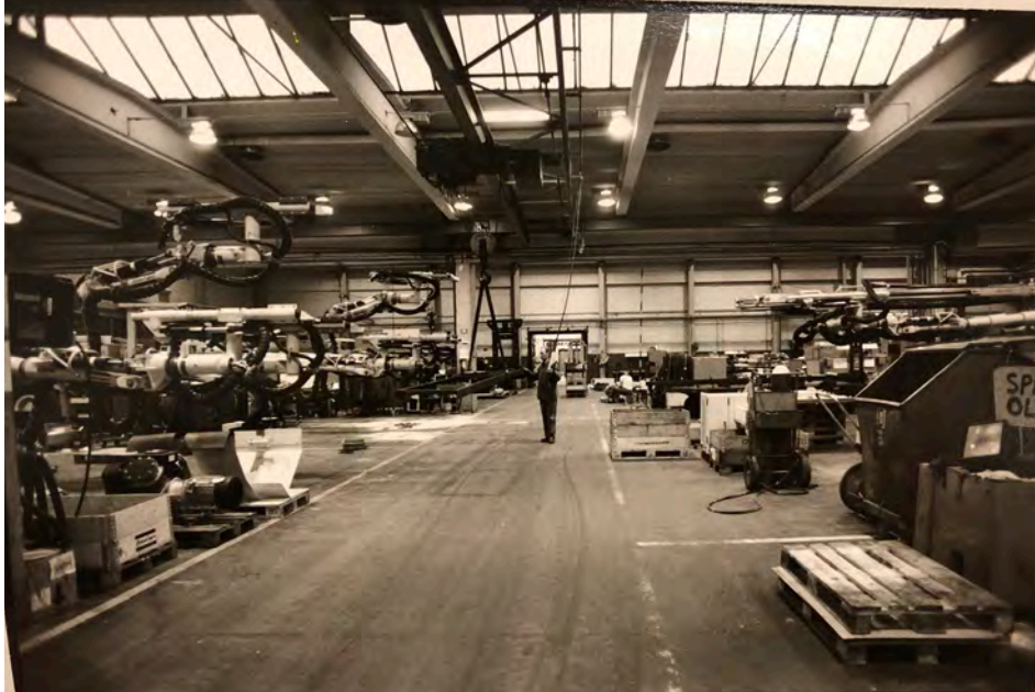
Simbaverkstaden 1992. På bilden syns lusinsläpp från taklanterninerna. Bild: Nackas lokalhistoriska arkiv.
