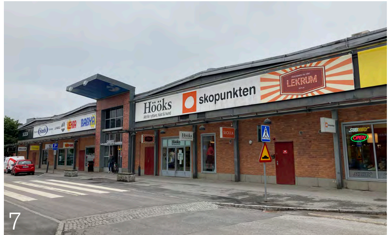
7 Norra fasaden med tydligt markerad entré. Stor variation på utformning och placering av skyltfönster och flertalet dörrar i rödkulör.
