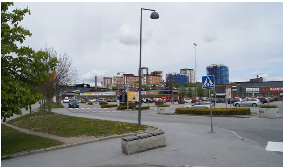
Parkering sträcker ut sig på den sydöstra delen. Bebyggelsen följer landskapet silhuett med lägre bebyggelse i dalgången vars höjd stiger tillsammans med landskapet. Pannrummets skorsten är tydligt avläsbar i landskapsbilden. Längs till göger
