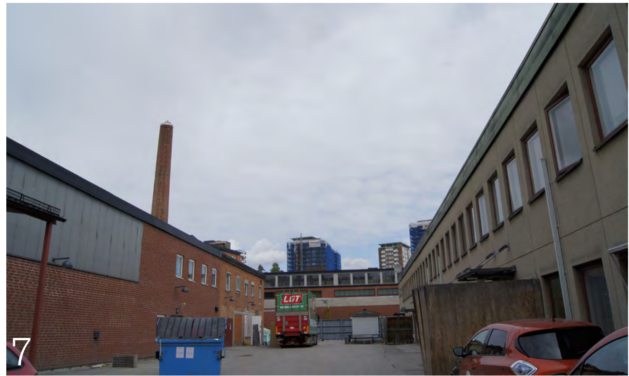
Panncentralen med anslutande nyare bebyggelse. Den östra sidan finns varuintag och avfallscontainrar.
